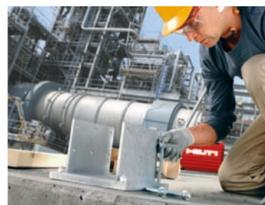
**Fissaggio di carpenteria metallica in acciaio e macchinari.** Per l'ancoraggio di una piastra di base di una colonna o un macchinario, HIT-RE 500 V3 fissa in modo sicuro gli elementi in acciaio al calcestruzzo.
