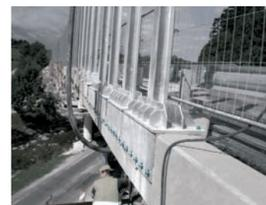
**Ancoraggio di barriere anti-rumore in caso di carico statico e dinamico.** In aggiunta a queste condizioni, è richiesta una elevata resistenza alla corrosione. HIT-RE 500 V3 incontra questo bisogno per applicazioni affidabili e durevoli nel tempo.
