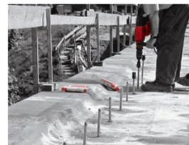
**Ancoraggio di cordoli** che non fanno parte della struttura primaria e sono separati dall'impalcato del ponte. La trave di bordo deve essere in grado di sopportare i carichi dovuti all'urto di un veicolo e del vento.
