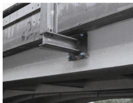
**Fissaggio affidabile di parapetti di sicurezza, torri faro, segnali luminosi, segnali stradali, giunti di dilatazione, cordoli o passerelle.** HIT-RE 500 V3 è ideale anche per applicazioni che richiedono ridotte distanze dai bordi e carichi elevati, come barriere bordo ponte, parapetti o soluzioni di ancoraggio temporanee con l'uso di bussole filettate internamente HIS-(R)N che ne consentono la successiva rimozione.
