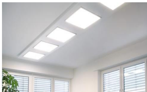
APPARECCHI DI ILLUMINAZIONE
