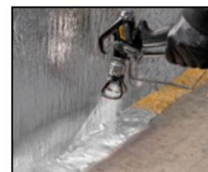
Applicazione del prodotto: spruzzare ininterrottamente per almeno 5-8 passate sulla stessa superficie per ottenere lo spessore richiesto.
