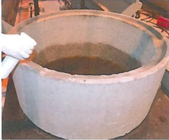
Immagini 1 e 2: Pretrattamento: inumidimento della piega della anello del pozzetto SR-F DN1000x500, Applicazione della schiuma poliuretanic rigida sulla piega.
