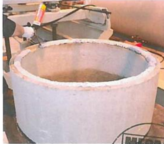
Immagini 1 e 2: Pretrattamento: inumidimento della piega della anello del pozzetto SR-F DN1000x500, Applicazione della schiuma poliuretanic rigida sulla piega.
