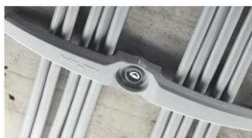
Fissaggio di cavi
