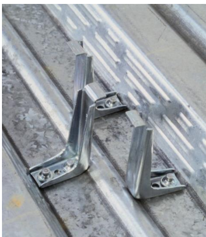
Figura 6 Hilti X-HVB installati su lamiera grecata
